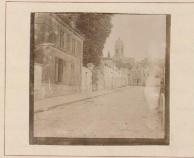
Clocher et Eglise (sur 1 re rue.)
